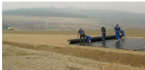
Рис. 2. Монтажные работы по формированию противофильтрационных экранов
