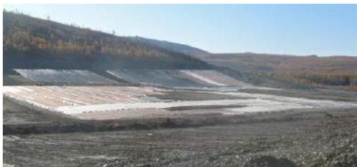
Рис. 1. Применение полиэтиленовых геомембран при формировании хранилищ промышленных отходов
